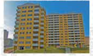
Köröglü İnşaat Göksu
